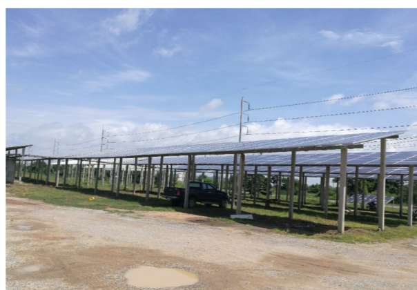
图为15kw组件安装现场。
