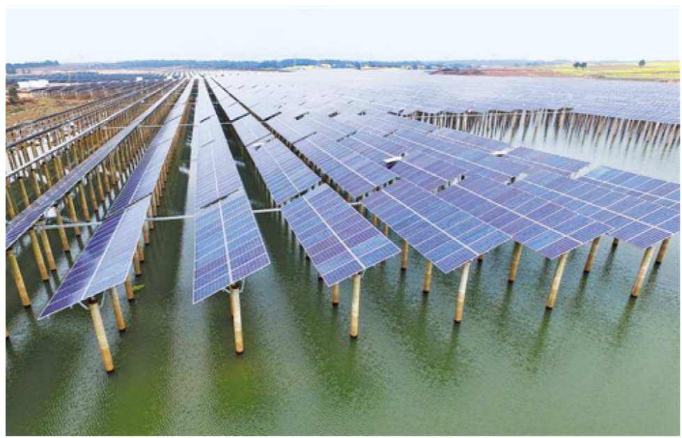
这是3月16日拍摄的江西奉新“渔光互补”光伏发电一期项目。近日,坐落于江西省宜春市奉新县跃进水库上的奉新“渔光互补”光伏发电项目一期35兆瓦光伏电站建成投运。该项目总投资12亿元,总装机容量110兆瓦,上层用于光伏发电,下层用于水产养殖,提高了单位面积土地和水域的经济价值。
